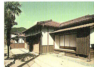
修復された甲8号
