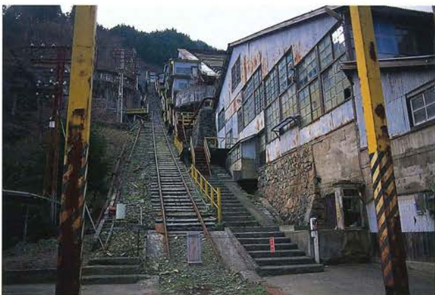
インクライン(傾斜軌道)
