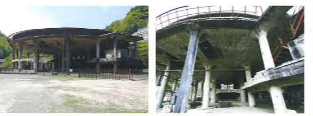
選鉱の最終行程である脱水・濃縮が行われた濾過装置。直径30mのものは、百尺シクナーと呼ばれていました。
